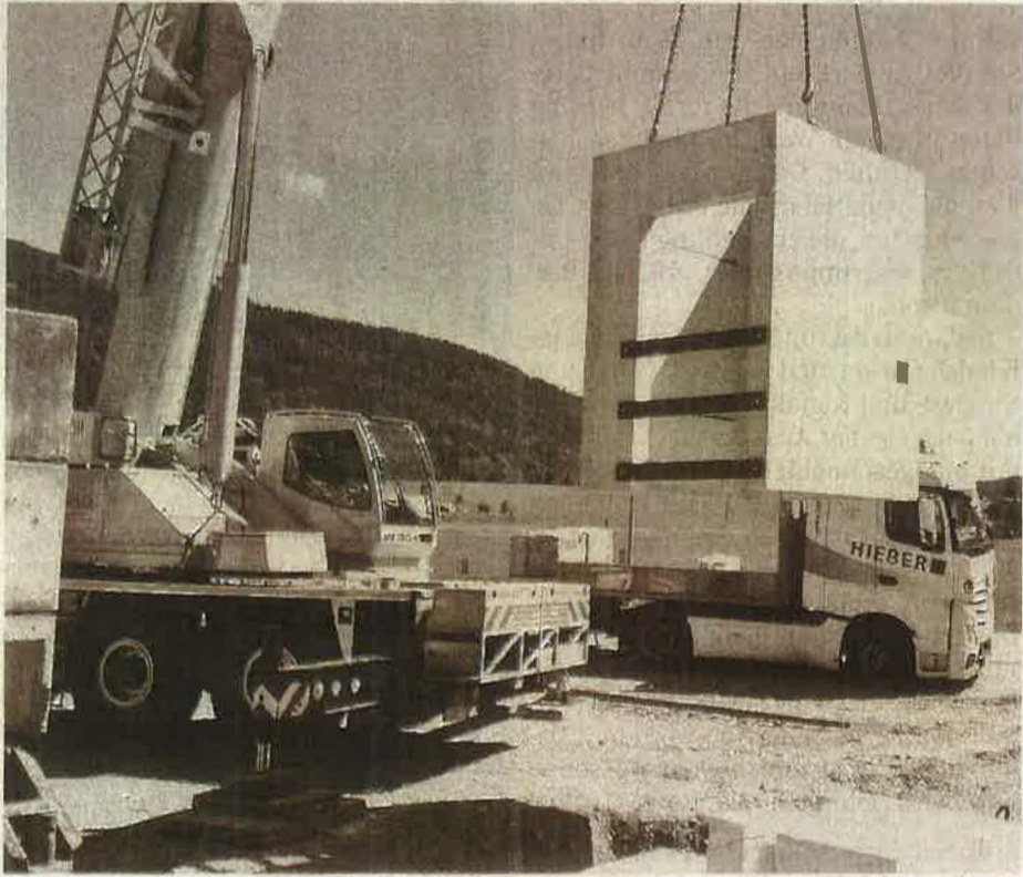
Die Schachtelemente werden vierseitig aus Beton gegossen und vollausgestattet auf die Baustelle geliefert. FOTO: HIEBER BETONFERTIGTEILWERK
