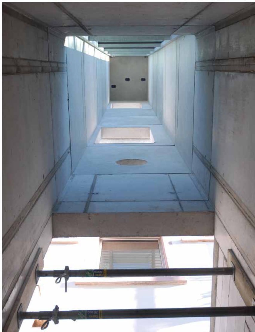
Die schlanken Schachtelemente werden vierseitig aus Beton gegossen und vollausgestattet auf die Baustelle geliefert. Das spart Zeit und Geld.
